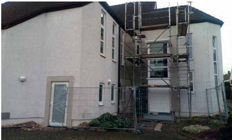
Letzte Bauarbeiten in Kerpen
