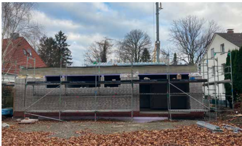
Im Lockdown begannen die Arbeiten am neuen Kirchengebäude für die Gemeinde Soest
