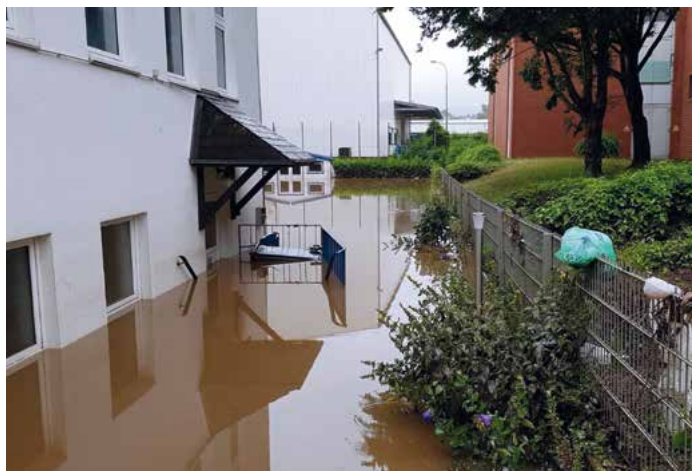
Hochwasserschäden in Eschweiler
