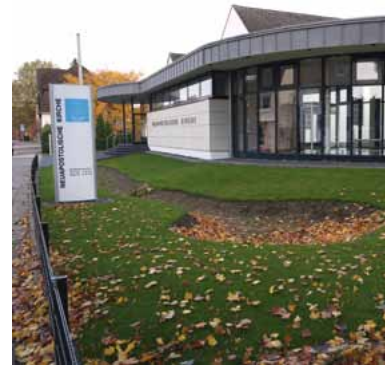
Die erweiterte Kirche in Castrop-Rauxel mit Regenwasserversickerungsanlage
