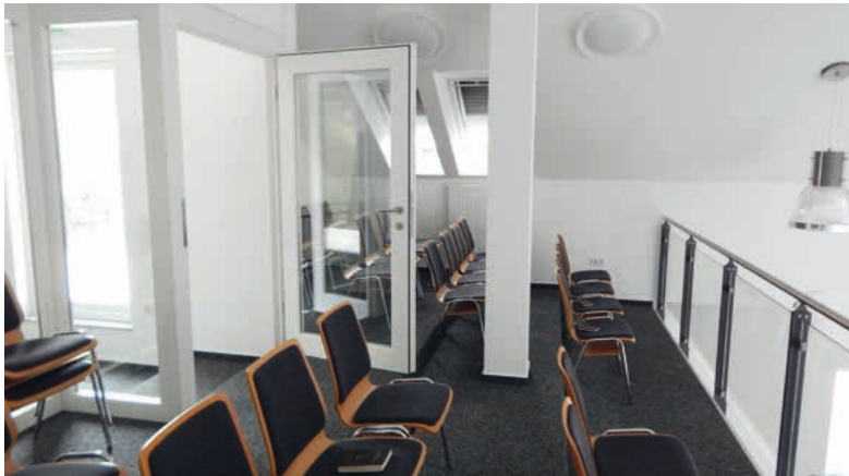
In Alzey wurde eine Empore eingebaut
