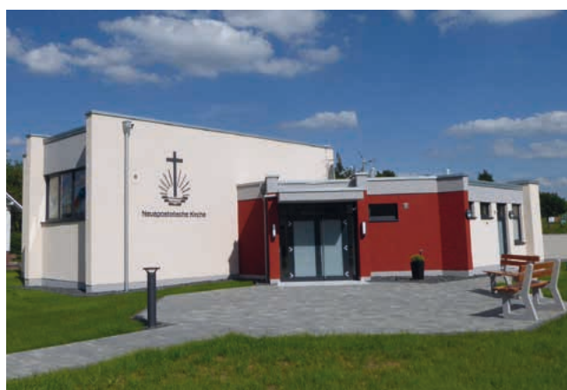
Außenansicht der Neupostolischen Kirche Hof/Westerwald
