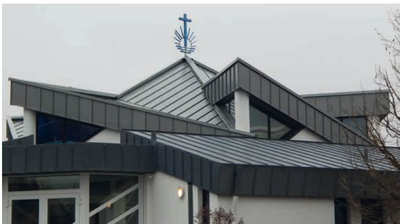
Für 13.000 Euro wurde das Dach in Groß-Gerau saniert
