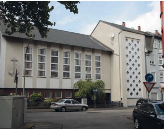
Die ehemalige neuapostolische Kirche Essen-Kray wurde von der „Church of Pentecost“ erworben und weiter als Gotteshaus genutzt
