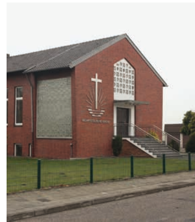
Das Kirchengebäude in Alpen wird abgerissen. Ein Investor baut hier 13 hochwertige Eigentumswohnungen
