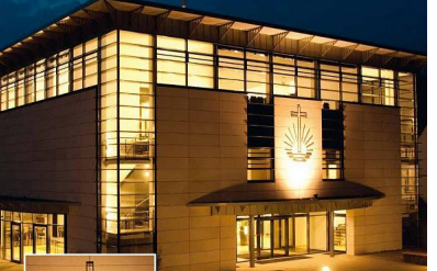
Das neue Hauptgebäude der Kirche in Nordrhein-Westfalen.
